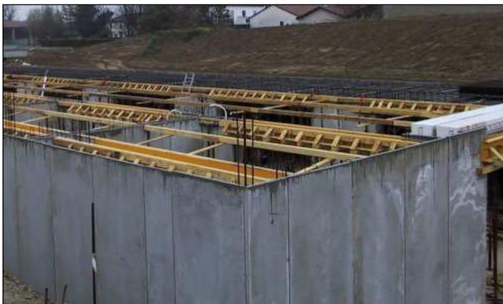
Si possono realizzare muri in cemento armato con **spessore** totale di 25 - 30 cm, secondo le esigenze statiche e d'impiego. **La larghezza** delle lastre é modulare di 120 cm con possibilità di realizzare elementi di lunghezza inferiore.
