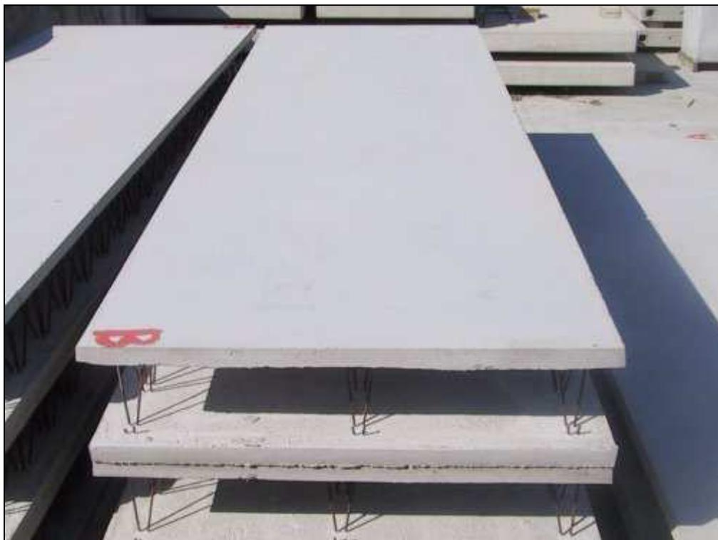
Sono costituite da due lastre parallele in calcestruzzo di spessore di 5 cm ciascuna, collegate tra loro per mezzo di tralicci elettrosaldati in acciaio che ne permettono la movimentazione e la posa in opera garantendo la solidità delle due componenti.
