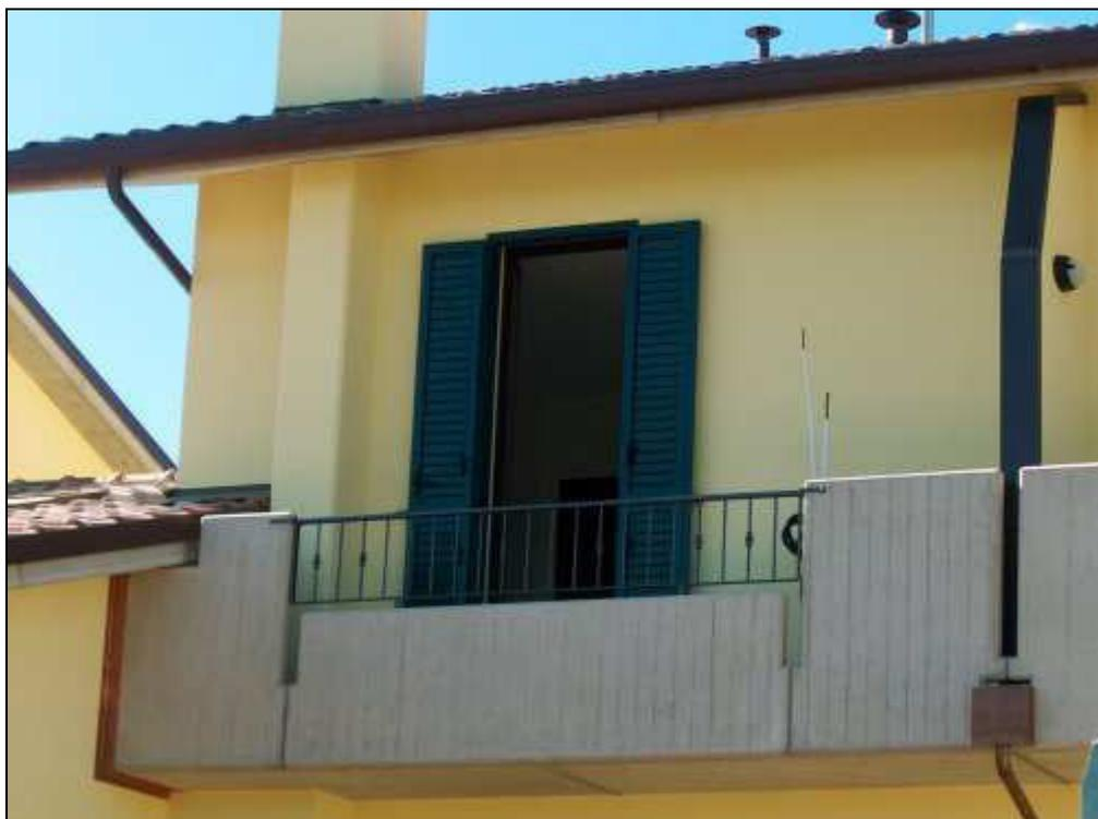
La finitura esterna può essere liscia contro cassero in ferro oppure utilizzando una matrice di legno a doghe verticali. Tutti gli spigoli sono opportunamente smussati. Per la movimentazione e il montaggio nel lato superiore sono predisposte delle boccole filettate a scomparsa.
