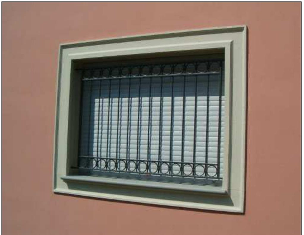
Cornicione realizzato tramite getto contro matrici in polistirolo rivestite in P.V.C.
