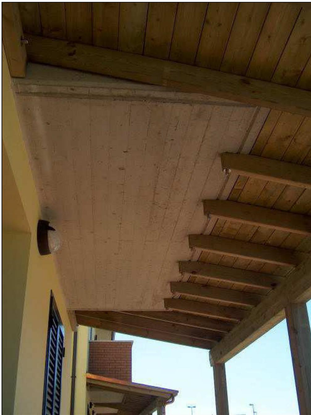
L'uso della lastra permette un coprifermo più sicuro dell'armatura inferiore del balcone o cornicione, essendo il getto eseguito in cantiere di prefabbricazione.
