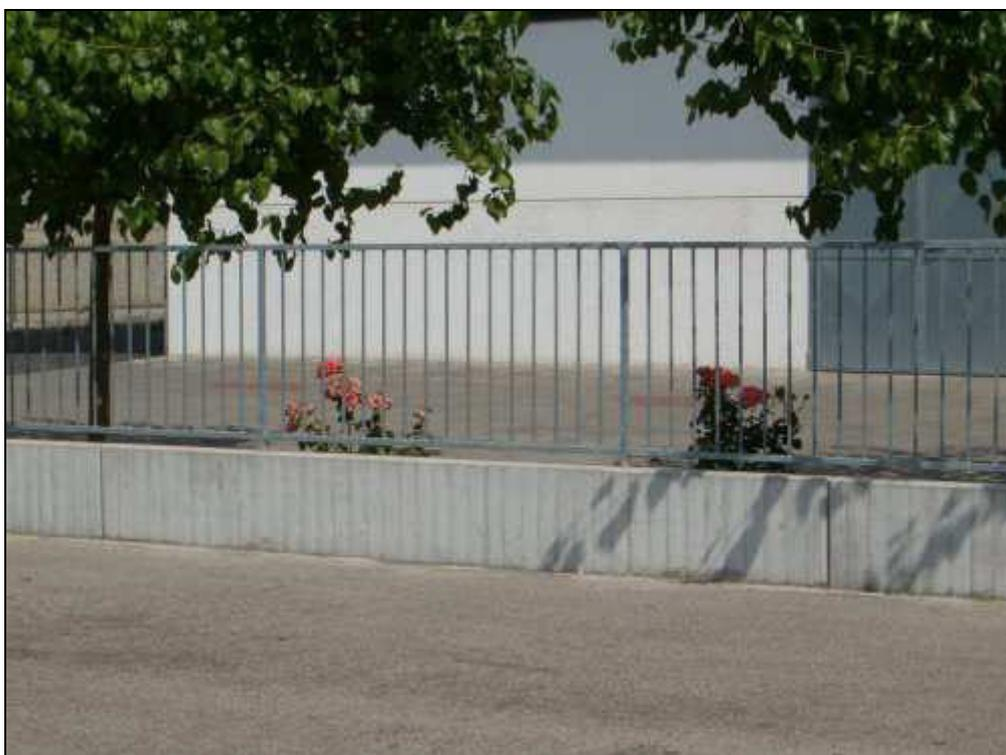
La finitura esterna può essere liscia contro cassero in ferro oppure utilizzando una matrice di legno a doghe verticali. Nel lato superiore si possono inserire dei fori, tondi  $\varnothing 63$  *mm* o quadrati  $80 \times 80$  *mm*, per il fissaggio della barriera di recinzione.
