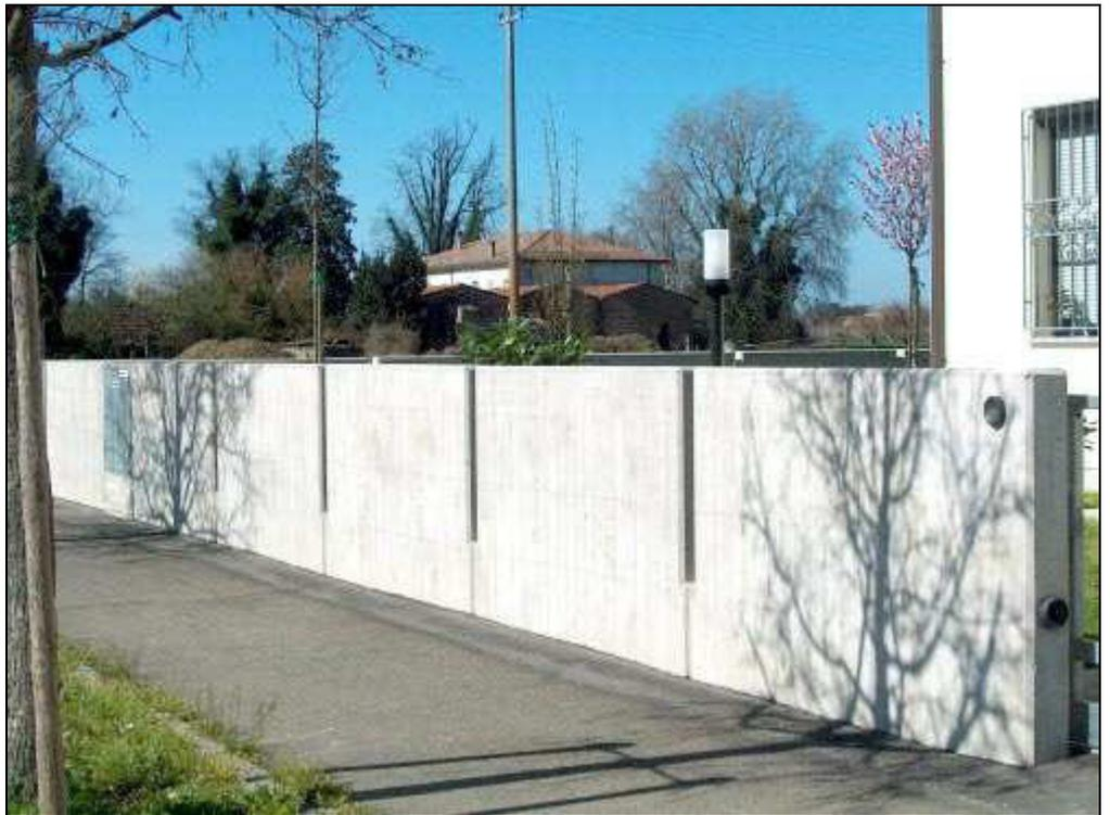
Sono realizzabili lavorazioni particolari come l'inserimento di scassi, tubi e scatole elettriche per la predisposizione dell'impianto per cancello automatico, del citofono o di cassette postali, box utenze, ecc ecc
